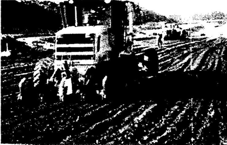
c) Com o trator com grade de disco ou enxada rotativa, destorroar o solo e facilitar o aparecimento de grandes pedras na pista a ser tratada;
