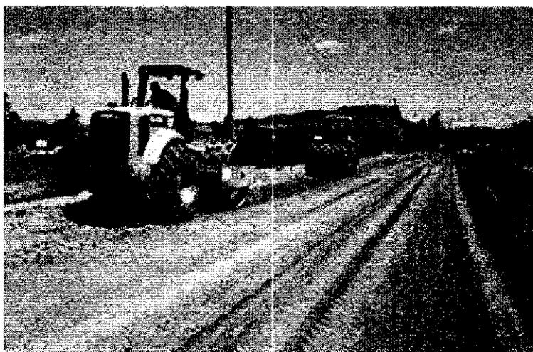
j) Com a motoniveladora conformar a plataforma (tirar excessos superficiais de solo); e,
