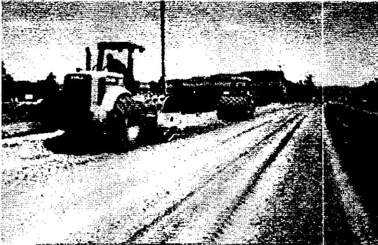
I) Com a motoniveladora conformar a plataforma (tirar excessos superficiais de solo); e,
