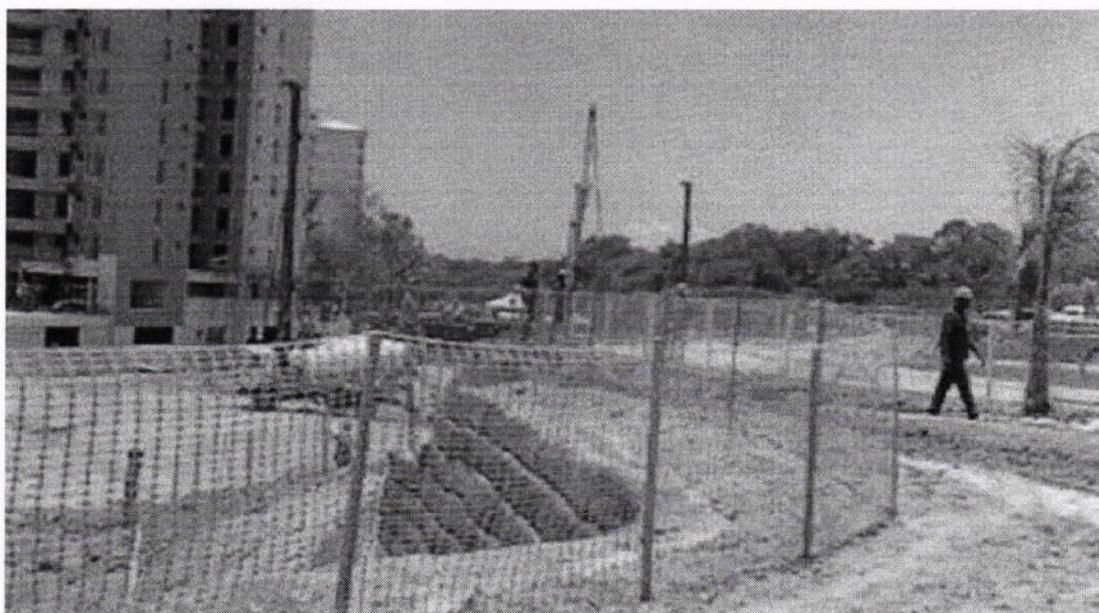
**Figura 31:** Referência de instalação da tela de segurança.
